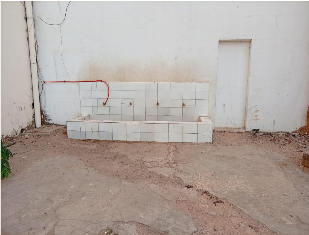
Fig.3 : Point d'eau du terrain d'EPS – configuration favorisant un gaspillage hydrique dû à un débit non contrôlé et à des périodes d'écoulement sans usage effectif (ablutions, lavage, etc.)
