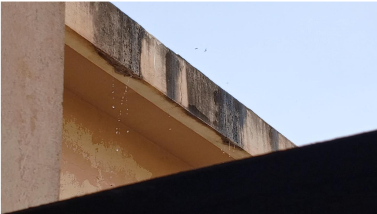
Fig.8 : Fuite réparée au niveau de la toiture du Bâtiment D | Lien vidéo : https://urli.info/1oIRh
