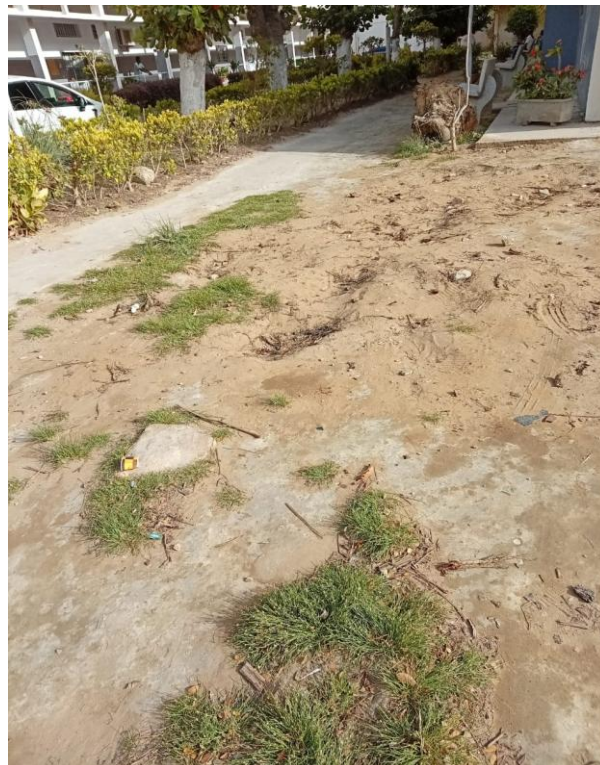
Fig.5 : Zones humides/boueuses du fait remontée nappe après réparation – cour principale (comparaison avant/après)
